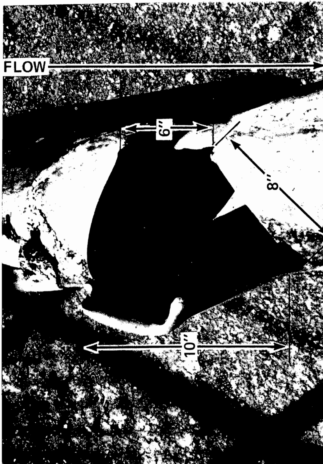
Figura 5.- Detalle de la ruptura de la tubería transportadora de productos de petróleo.
